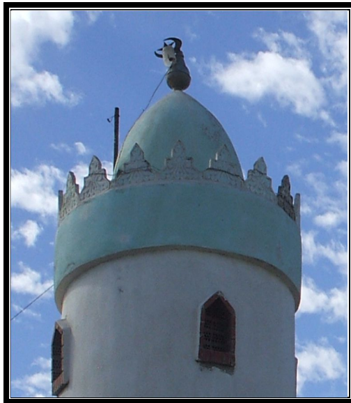
الصورة رقم: 83 القببية التي تغطي المئذنة
