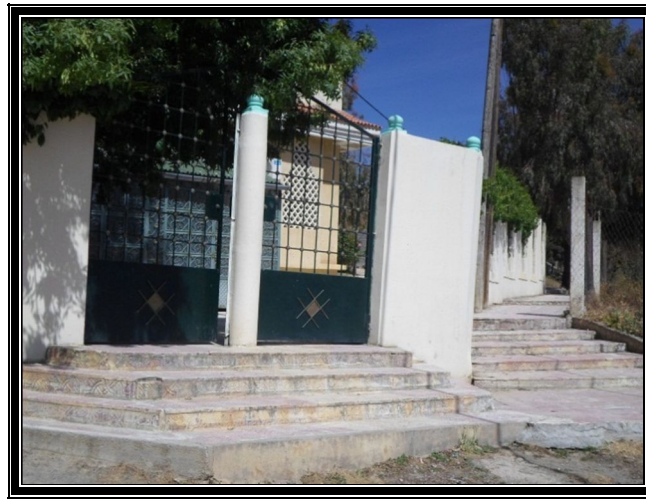
الصورة: 07 المدخل الجنوبي
