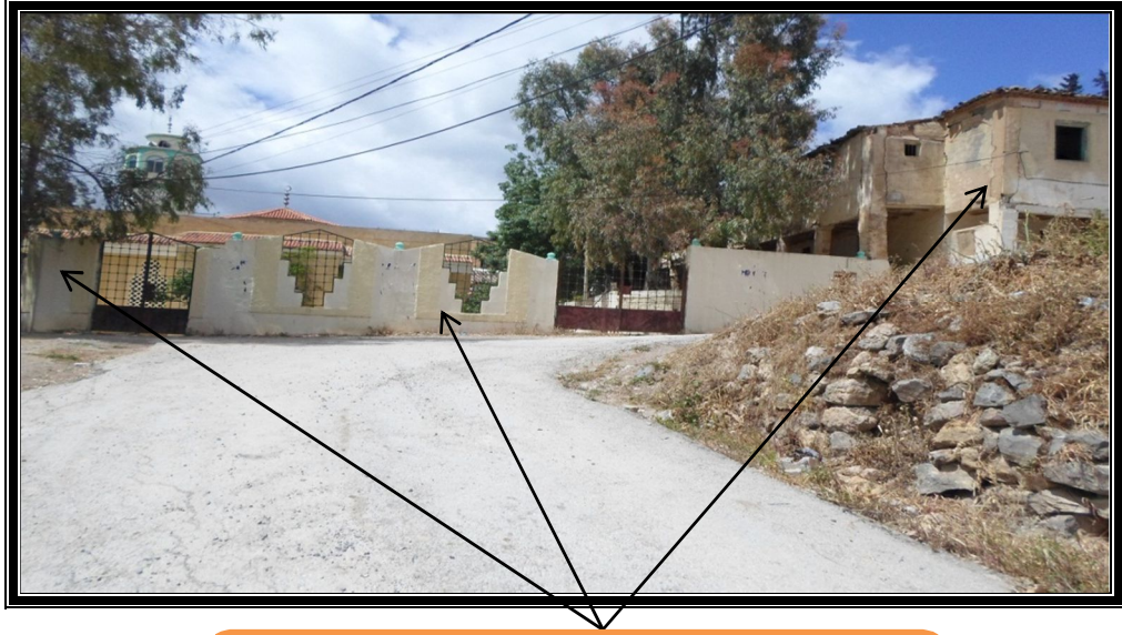
الصورة رقم: 01 الواجهة الشرقية
